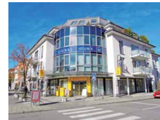
Das alte Postgebäude (oben) und die Post in der Bahnhofstraße 34 heute.
